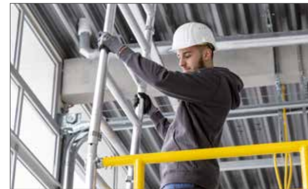
Weitere Aufsteckrahmen einsetzen
