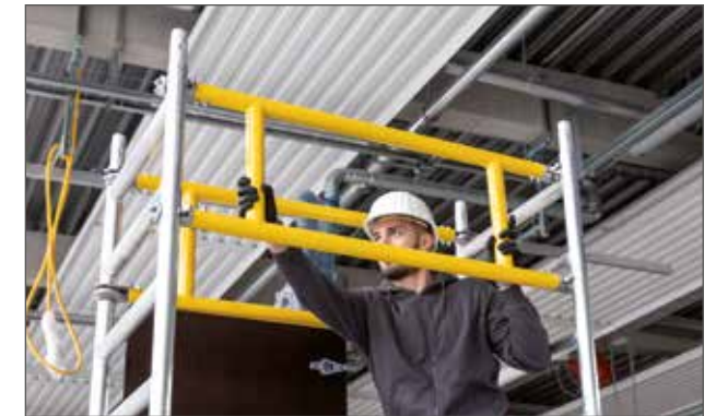
Montage im absturzesicherten Bereich dank 3-T-Methode
