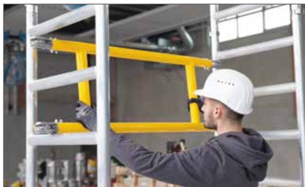
Pulverbeschichtete Geländerrahmen als Querstreben
