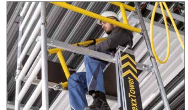
Obere Geländer und Bordbretter montieren
