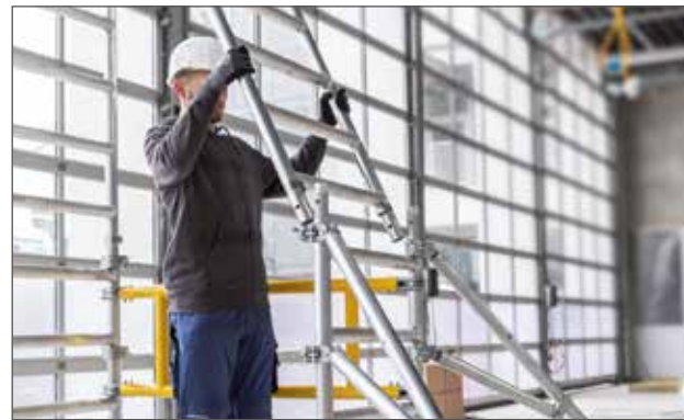
Intuitive Steckverbindungen mit Federclips
