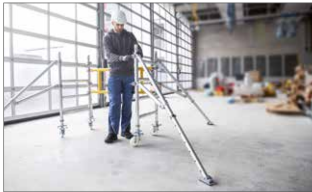
Einfache Montage der Ausleger für sicheren Stand
